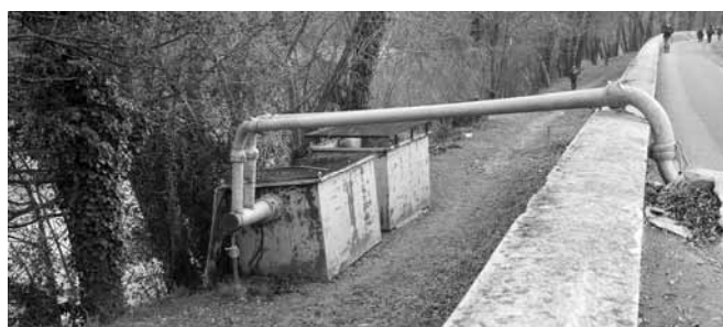
Drainage de l'eau pour assécher les fondations des immeubles en construction de la Zac Blanche Monier
